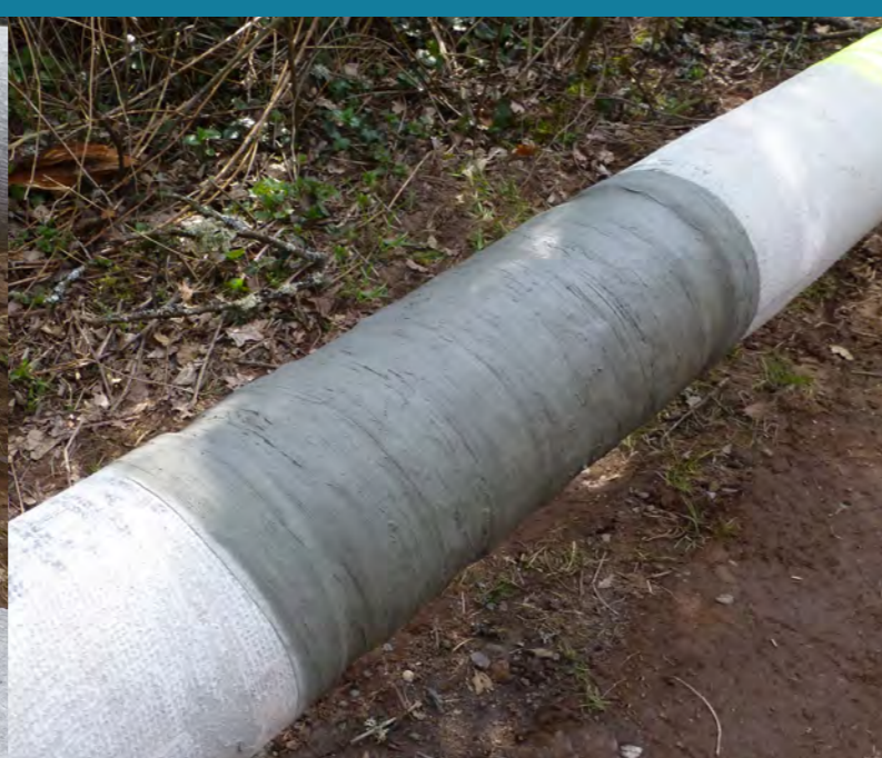
Schweißverbindung DN 150
