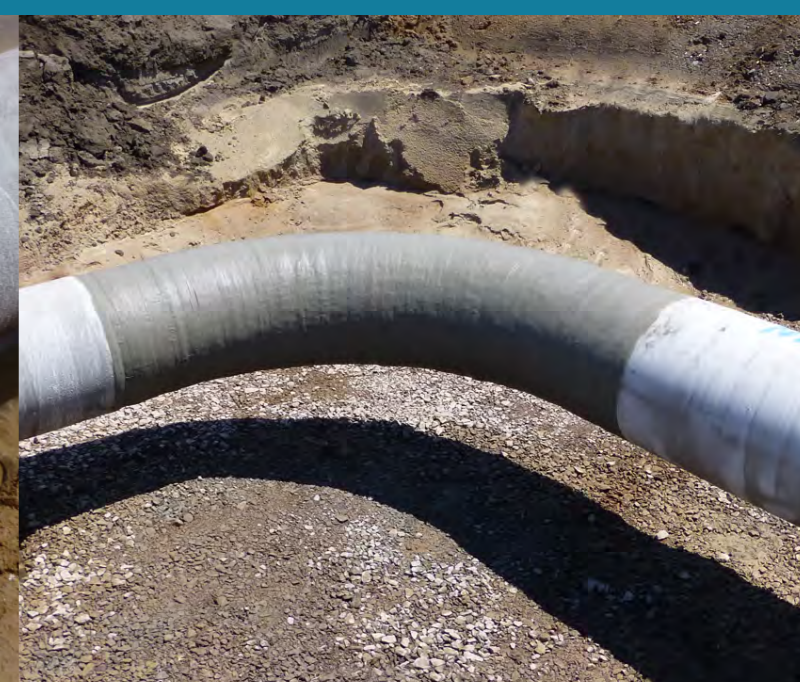
Rohrbogen DN 500 D5 90°
